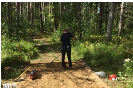
Les sentiers de l'aire de conservation Robert Graham à South Dundas ont été remis en état et de nouveaux ponceaux ont été installés pour aider à atténuer les problèmes d'inondations saisonnières.
