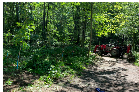
La CNS va restaurer l'aire de conservation J. Henry Tweed à Russell grâce à un nouveau partenariat de 3 ans avec Ontario Power Generation. Les travaux de restauration comprendront l'enlèvement des frênes, la plantation d'arbres indigènes, la réparation de l'érosion et la stabilisation des berges.
